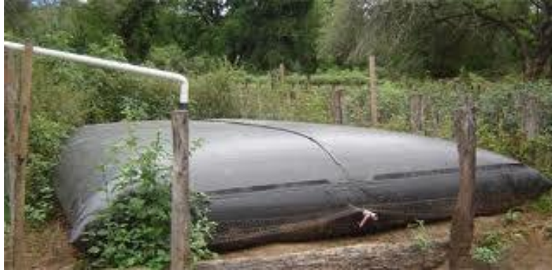
Figura 4, Biodigestor hecho de geomembrana de polietileno de alta densidad.
