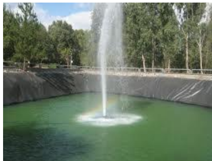
Figura 10, Reservorio de agua impermeabilizado con geomembrana.
