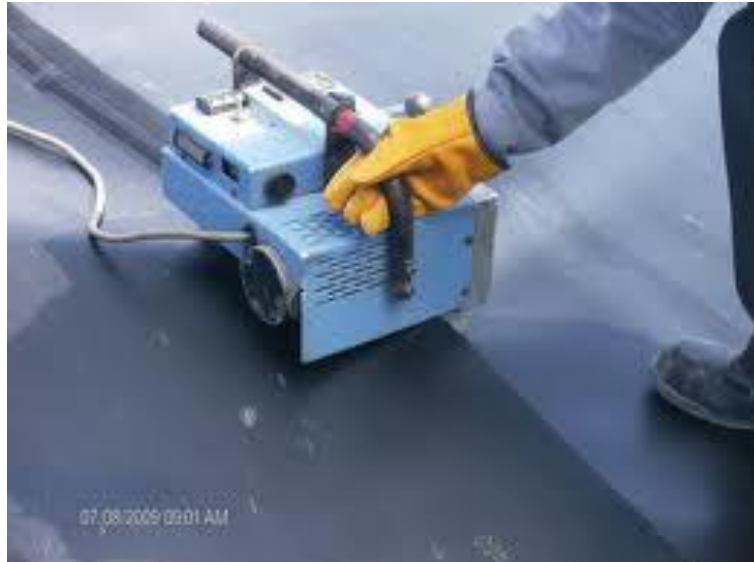
Figura 3, Soldadura por extrusión.
